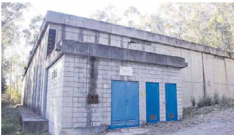
Depósito de agua de Coiro, donde se almacena y regula el agua de Cangas. | Santos Álvarez
